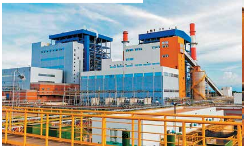
El objeto del contrato con el consorcio chino era construir, instalar y poner en operación la tercera planta de generación termoeléctrica en el municipio de Puerto Libertador, Córdoba.
